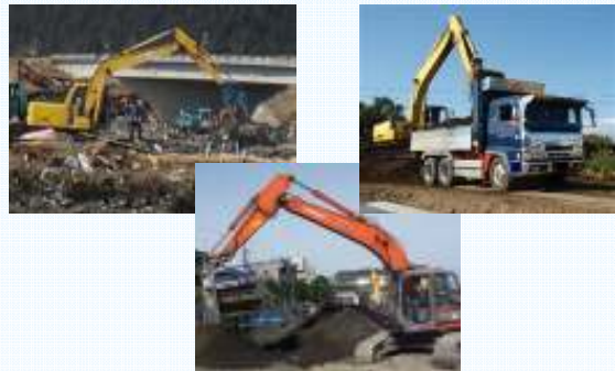
撤去及び分別、積み込み作業
